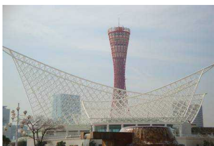
神戸ポートタワー
