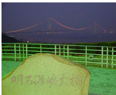
淡路島側から見た明石海峡大橋
